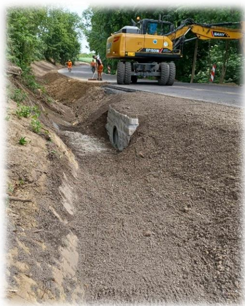
Przebudowa z rozbudową drogi Zielnowo-Fijewo
