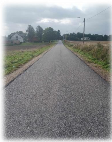
1366C Szembruk-Szembruk st. kolejowa
