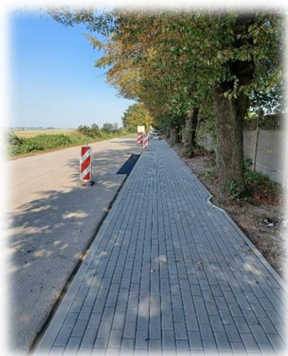
Budowa drogi dla pieszych w miejscowości Linowo
