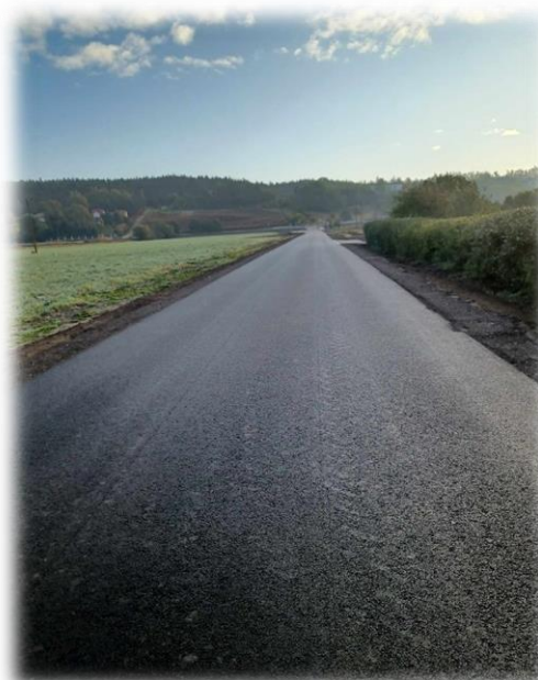
Przebudowa z rozbudową drogi Grudziądz-Gać
